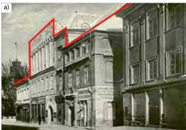
15 pav. Pilies g. 2–6 vaizdas 1939 m. (a) ir 2009 m. (b). Karnizo linija pakito dėl atsiradusių nebūdingų tūrinių švieslangių Fig. 15. The view of Pilis street 2–6 in 1939 (a) and 2008 (b). The line of cornice is negatively changed
