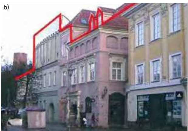
15 pav. Pilies g. 2–6 vaizdas 1939 m. (a) ir 2009 m. (b). Karnizo linija pakito dėl atsiradusių nebūdingų tūrinių švieslangių Fig. 15. The view of Pilis street 2–6 in 1939 (a) and 2008 (b). The line of cornice is negatively changed
